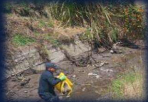
Limpieza vía antigua Puembo - Tababela
